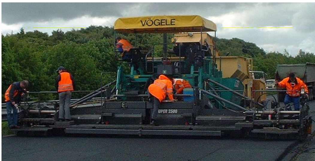
Figuur 1. Aanleg proefvak.
