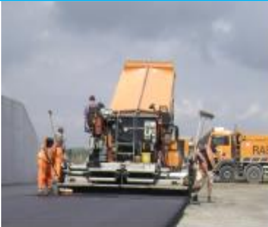
Verwerking van 100 % gerecycled asfalt.
