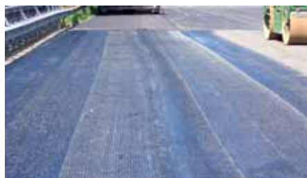
Project ligt gereed om over de hele breedte een deklaag aan te brengen.
